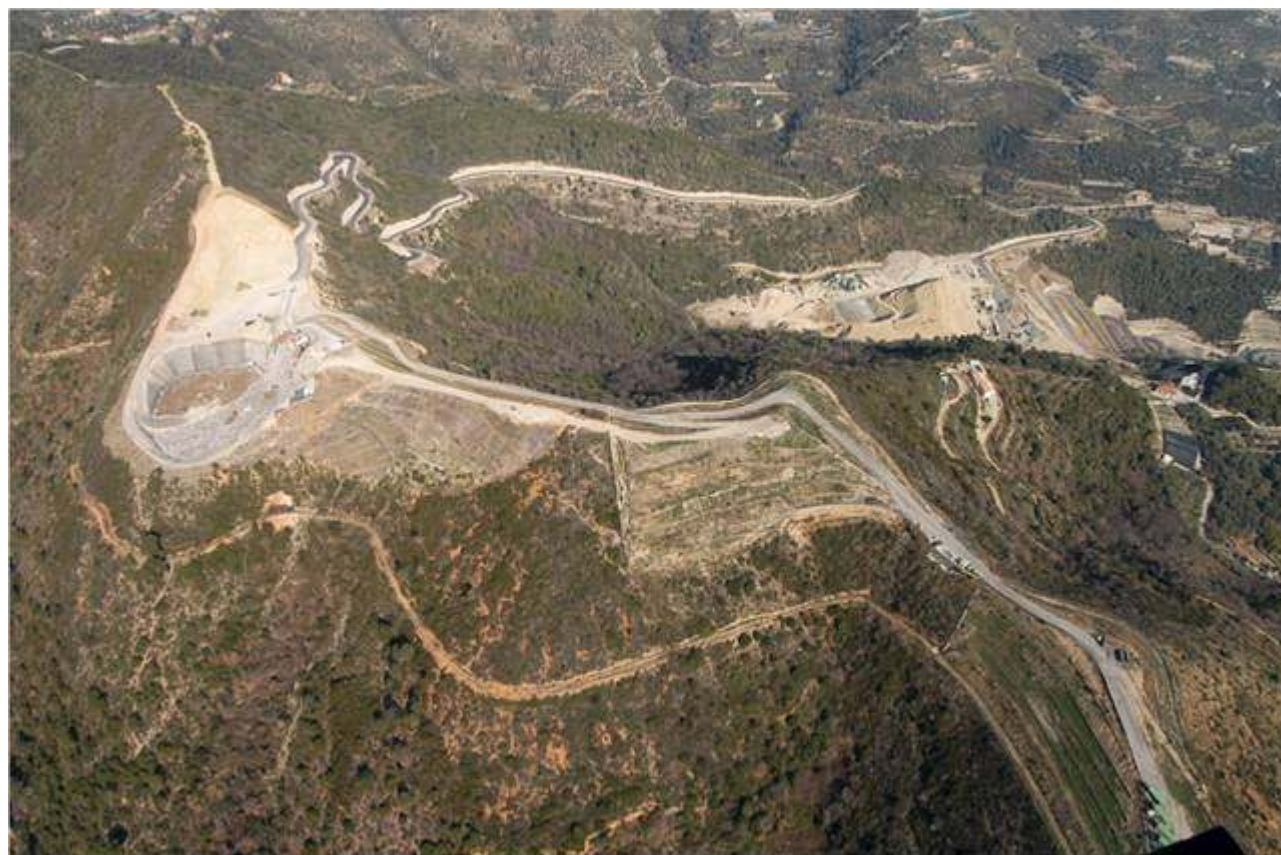
Veduta aerea sul crinale del sito di discarica
