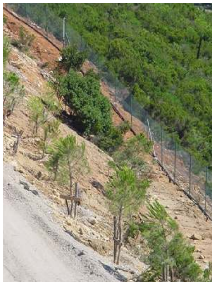
Ripristino ambientale su discarica ultimata
